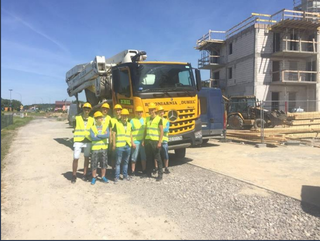
02 czerwca 2017 roku uczniowie klasy III technik budownictwa odwiedzili plac budowy.
